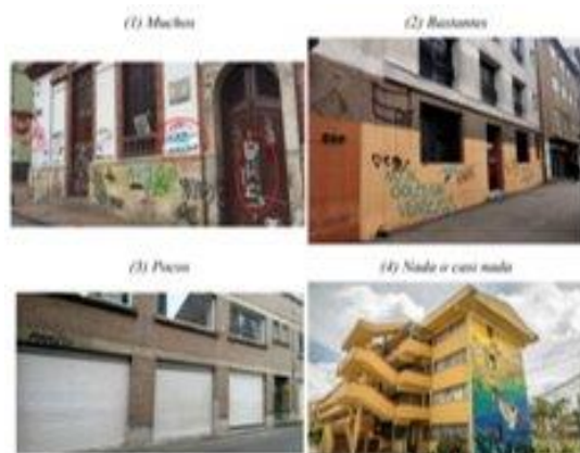
Ilustración 9: Hoja de ruta: Ejemplos de grados de rayados/vandalismo
